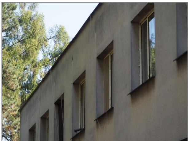
Větrací otvory z podstřešního prostoru.
